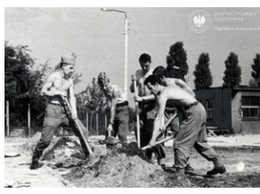
Prace przy przebudowie placu apelowego w jednostce ZOMO w Katowicach-Piotrowicach, sierpień 1965 r.
