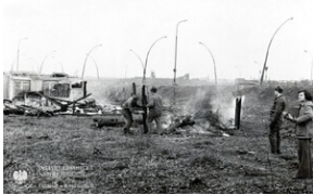
Przygotowanie terenu pod budowę gmachów KW MO w Katowicach, kwiecień 1975 r.
