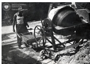
Prace przy budynku mieszkalnym i sztabowym ZOMO w Katowicach-Piotrowicach, 1965 r.
