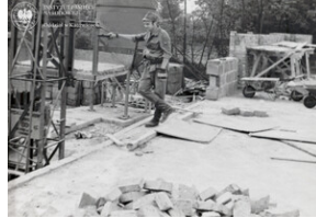
Budowa budynku mieszkalnego dla rodzin funkcjonariuszy ZOMO, wiosna/lato 1978 r.
