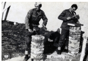
Budowa strzelnicy sportowo-szkoleniowej dla garnizonu katowickiego, 1965 r.
